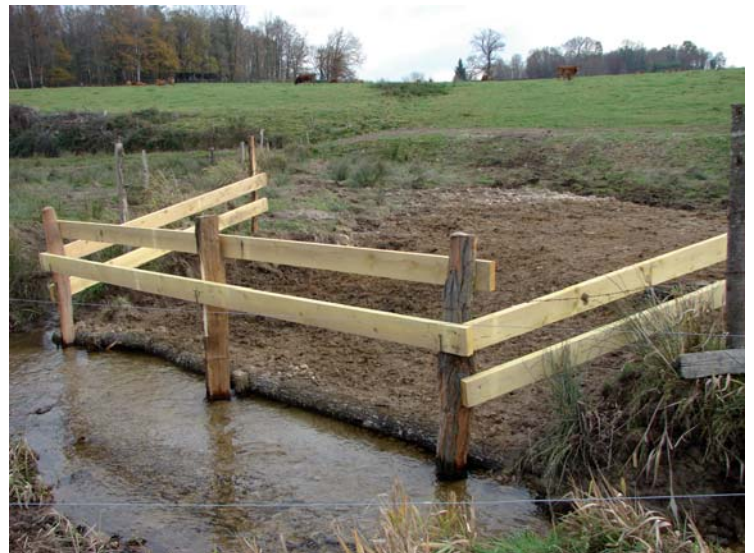
La même zone après travaux - © CCCSO
