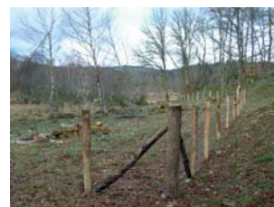
Pose de clôture fixe
